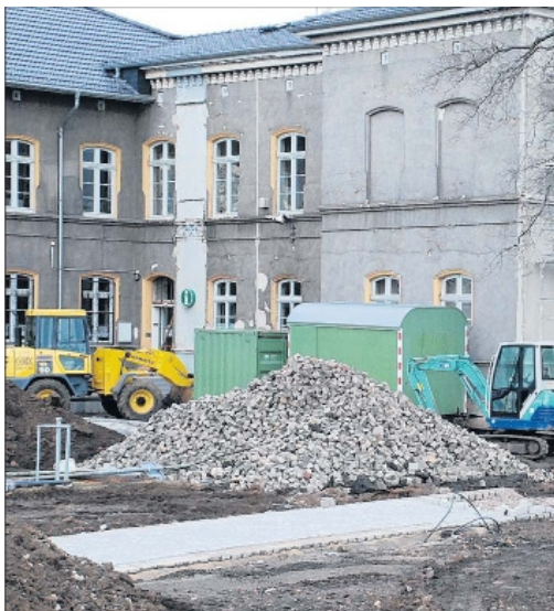
Bis zum 26. April laufen die Arbeiten im Kaligarten und an der ehemaligen Kaliverwaltung. Mit ihrer Wiedereinweihung wird das IBA-Jahr in Staßfurt am 29. April eröffnet.
