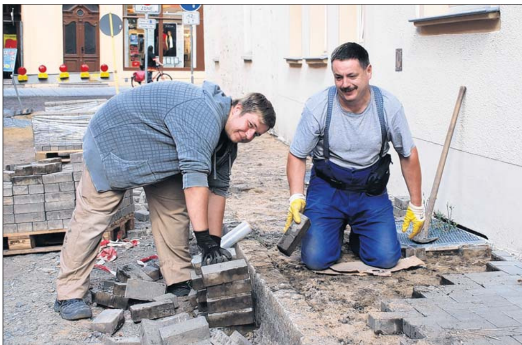
Die Mitarbeiter der Staßfurter Baubetriebe, Carsten Priese (links) und Frank Kuitzsch, nehmen im Tränental vor dem Haupteingang des Theaters das Altstadtpfaster wieder auf. Es wird zwischengelagert und an anderer Stelle wieder verwendet werden. Foto: René Kiel
